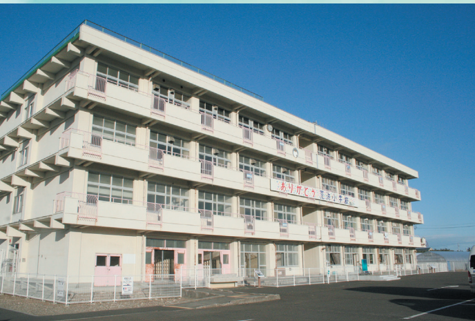
被災した校舎がそのまま残る「震災遺構 仙台市立荒浜小学校」
